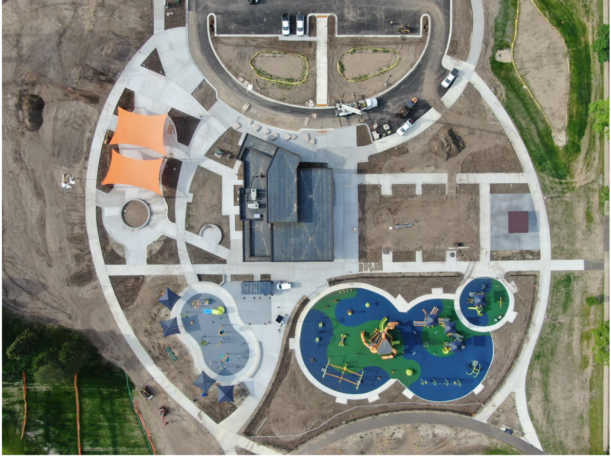
Commons Park Construction 5-27-2026
