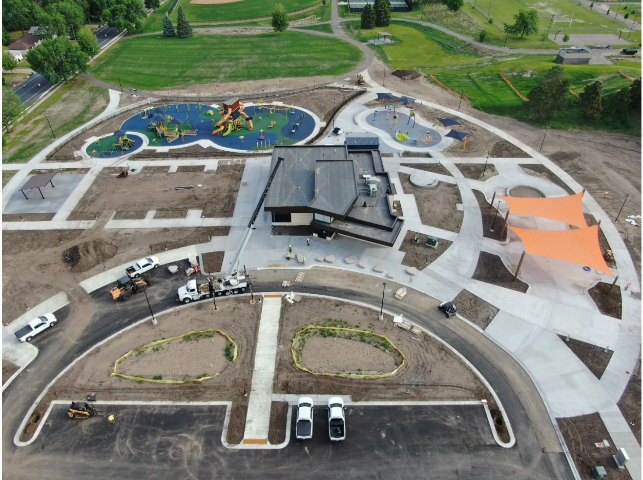
Commons Park Construction 5-27-2026
