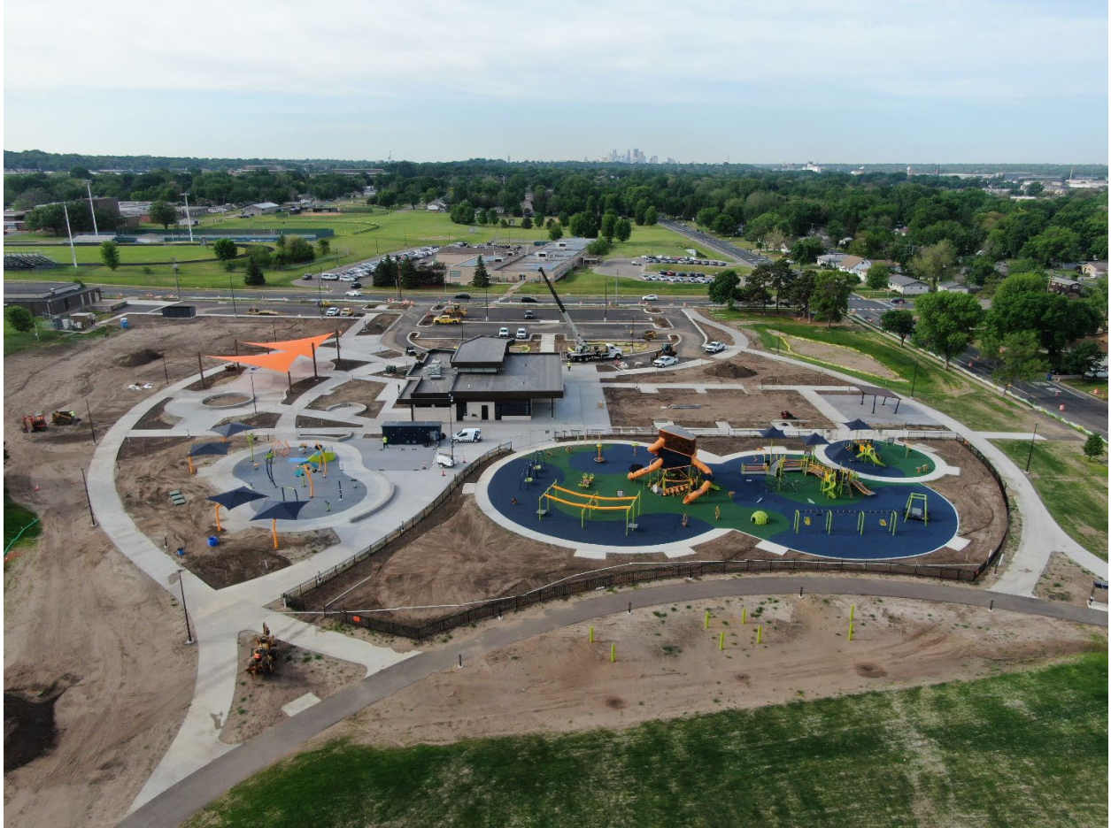
Commons Park Construction 5-27-2026
