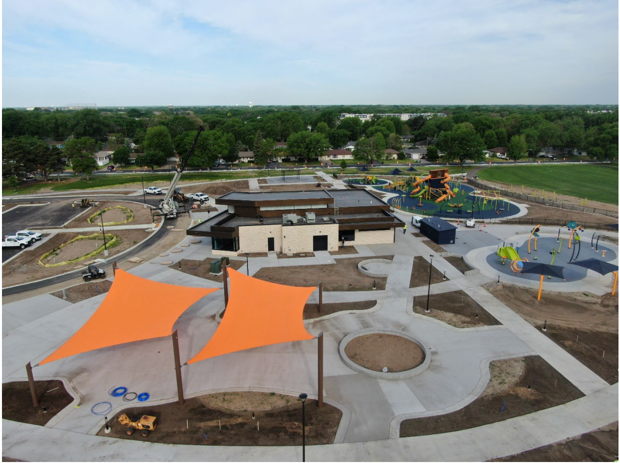
Commons Park Construction 5-27-2026
